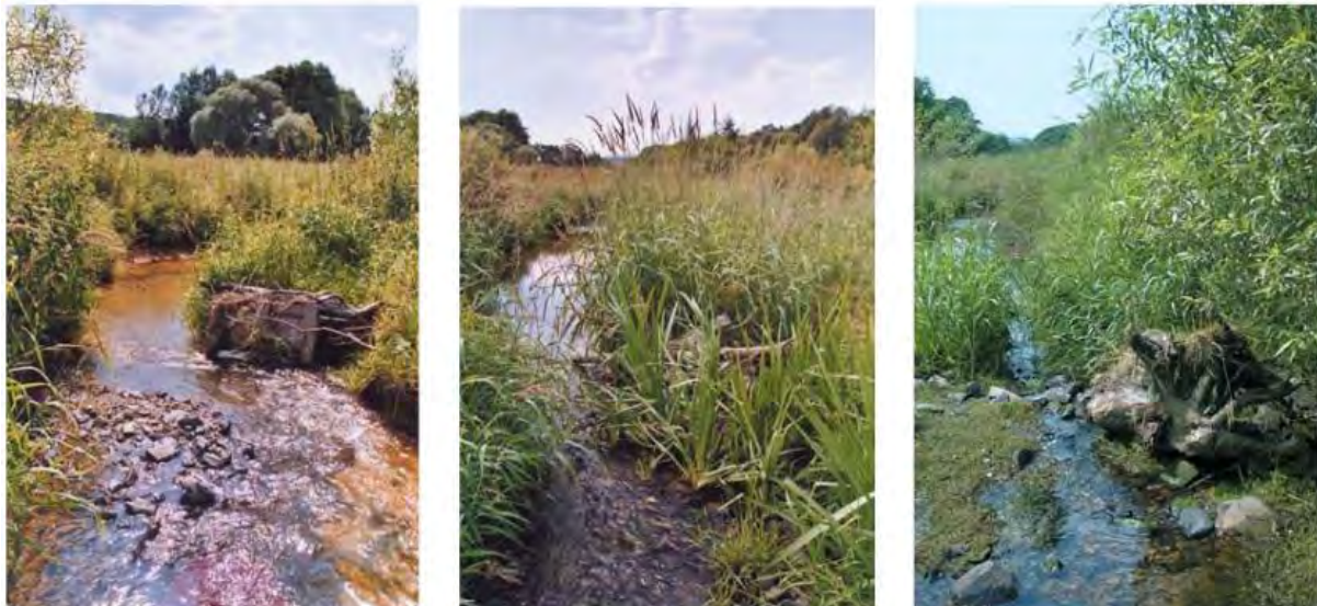
Abbildung 26: Erhöhung der Strömungsdiversität durch Einbringung von Strukturelementen [14]
