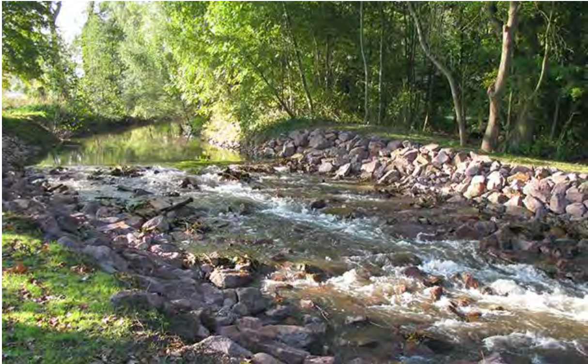
Abbildung 15: Beispiel Sohlgleite mit Niedrigwasserrinne als punktuelle Maßnahmenvariante
