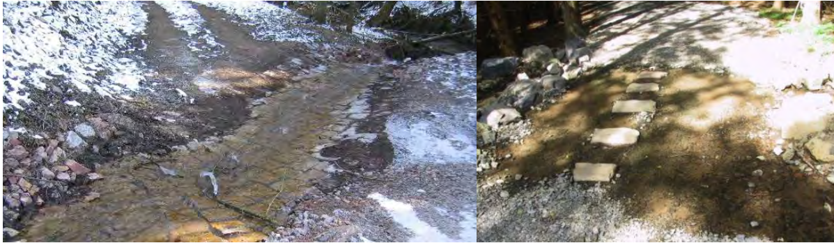
Abbildung 19: Ausführungsbeispiel für Furten. Links grob verlegte Steine, rechts einzelne Trittschritte. Quellen: T. Kowalke, Gerhard Schlösser
